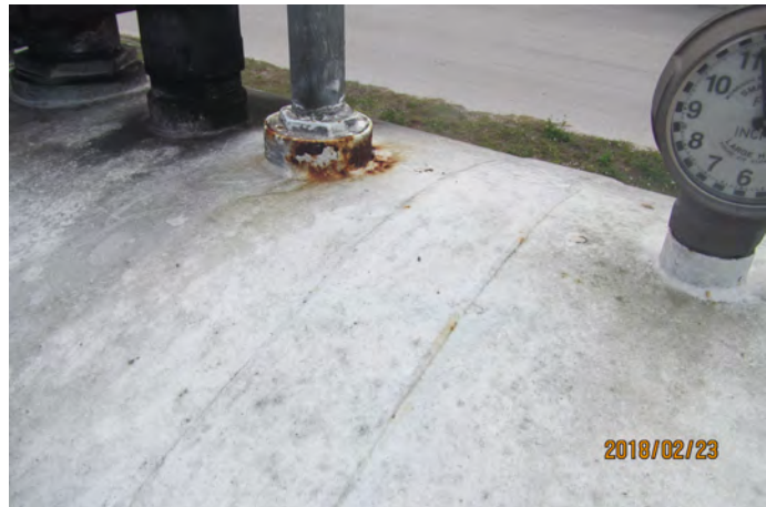
2018-02-23 TCI Monitor Corrosion
