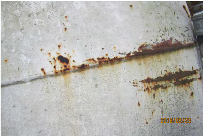
2018-02-23 TCI Monitor Corrosion
